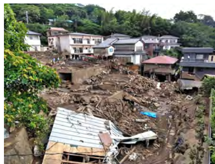
画像1：土石流の現場（静岡県熱海市）
